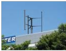
Die Kleinwindenergieanlage ... von Ritter Elektronik arbeitet mit einer Vertikalachse. Bilder: Ritter Elektronik
